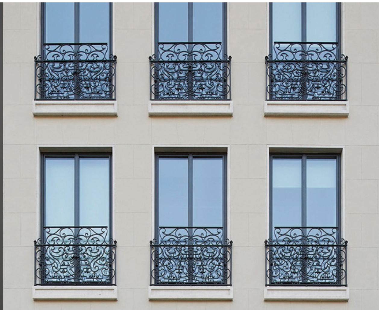
Finestre a due ante con sezioni costanti da 62 mm, sia nel perimetro sia nel nodo centrale.
