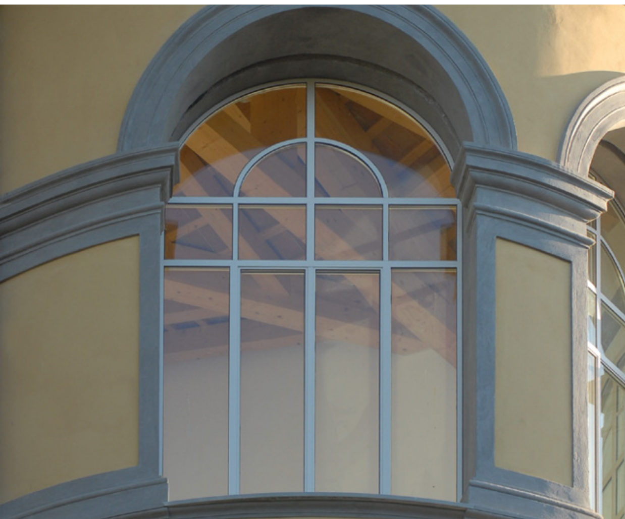
Menuiserie avec vitrages non coplanaires et ouvertures en évidence. Variante 1 d'OS2 pour des menuiseries type fenêtre traditionnel.
