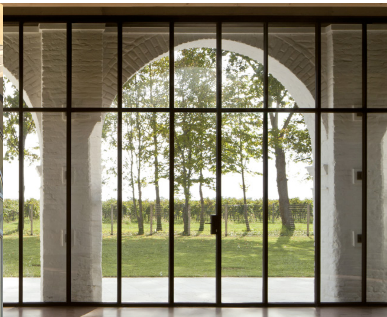
Menuiserie avec vitrages coplanaires et profils indifférenciés entre fixes et ouvrants qui rendent les ouvertures imperceptibles. Variante 2 d'OS2 pour des menuiseries type Secco.
