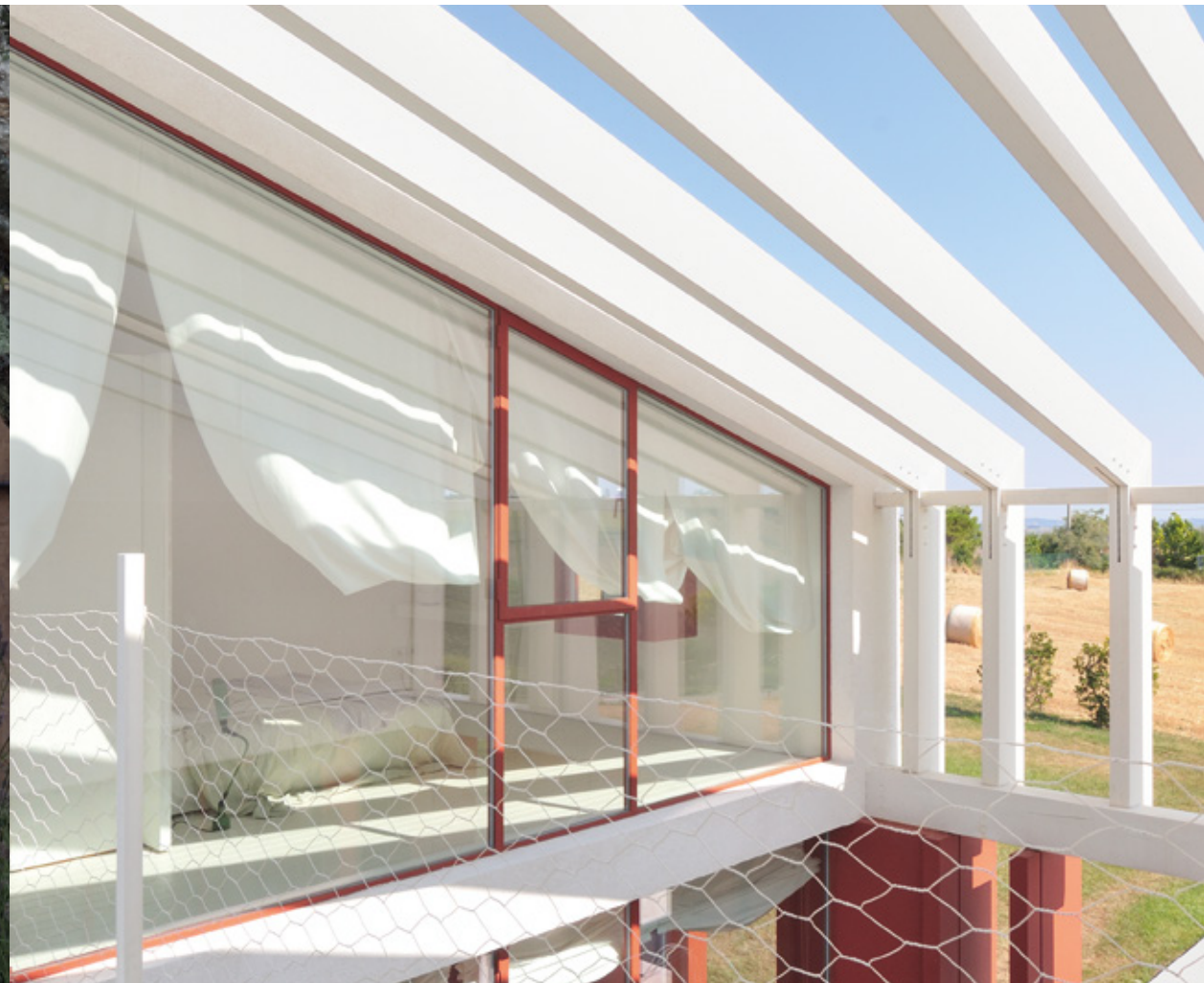
Fenêtre à un vantail avec nœuds constants sur tout le périmètre, aussi celui fixe inférieur
