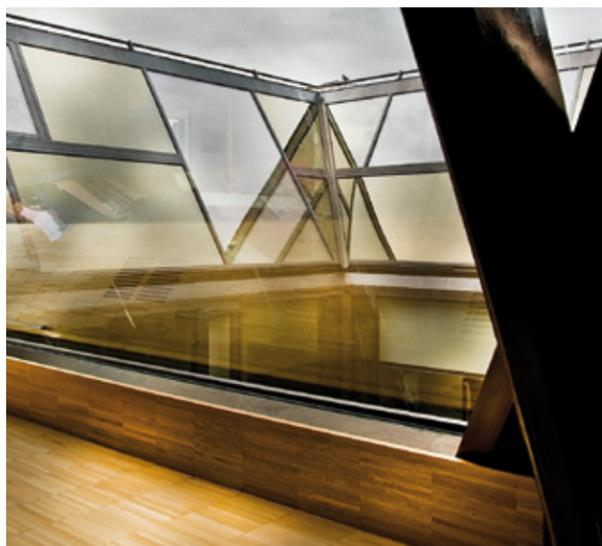
Avec **4F 2** - système de murs rideaux rapporté pour les façades vitrées de grandes dimensions - on peut utiliser et combiner à l'intérieur et à l'extérieur des matériaux différents tels que l'acier, l'acier inox, le corten, le laiton et le bois.
