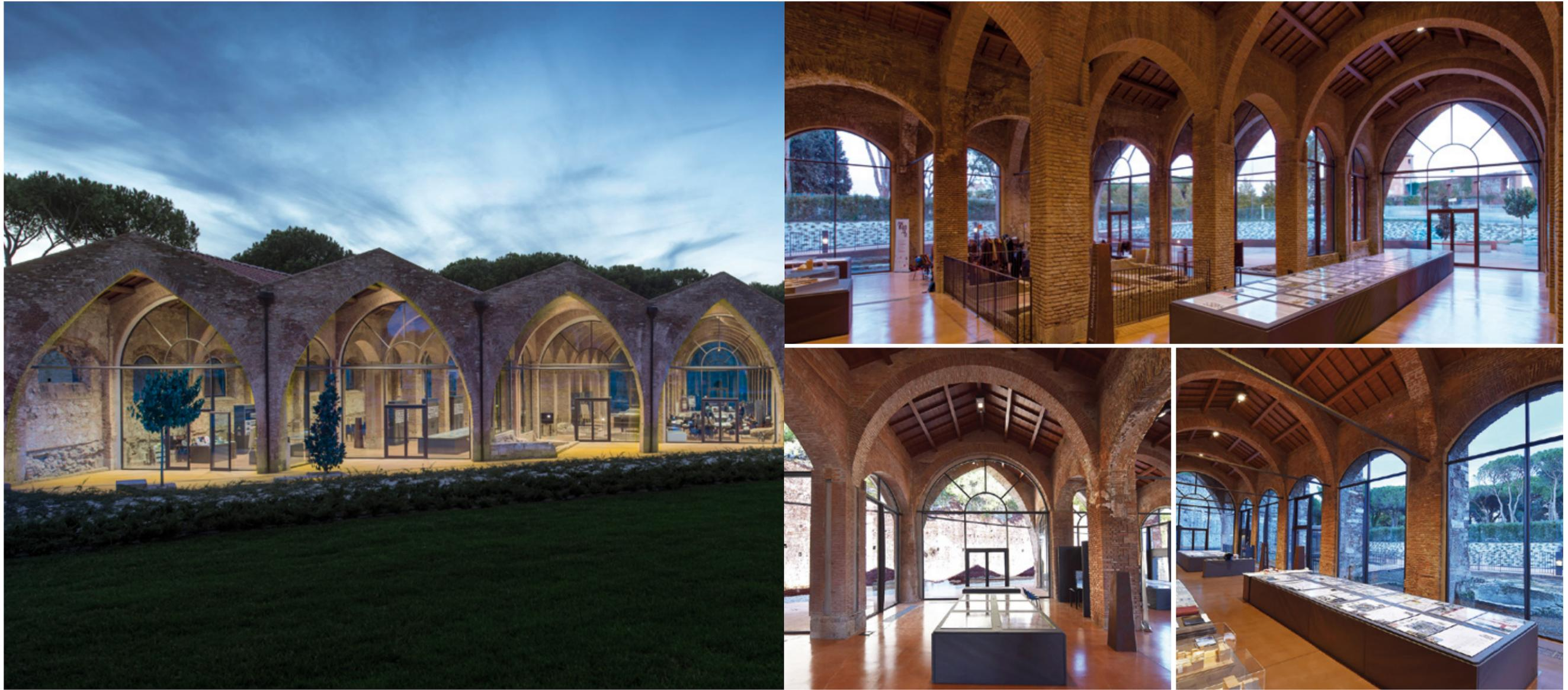
Dans la restauration philologique des arsenaux pisans, les structures des arches du XIVe siècle sont mises en évidence par la dématérialisation des fermetures, remplacées par de vastes baies vitrées. Délicat et essentiel le rôle confié aux murs rideaux et aux menuiseries : 4F 2 et SA 15 de Secco Sistemi.
