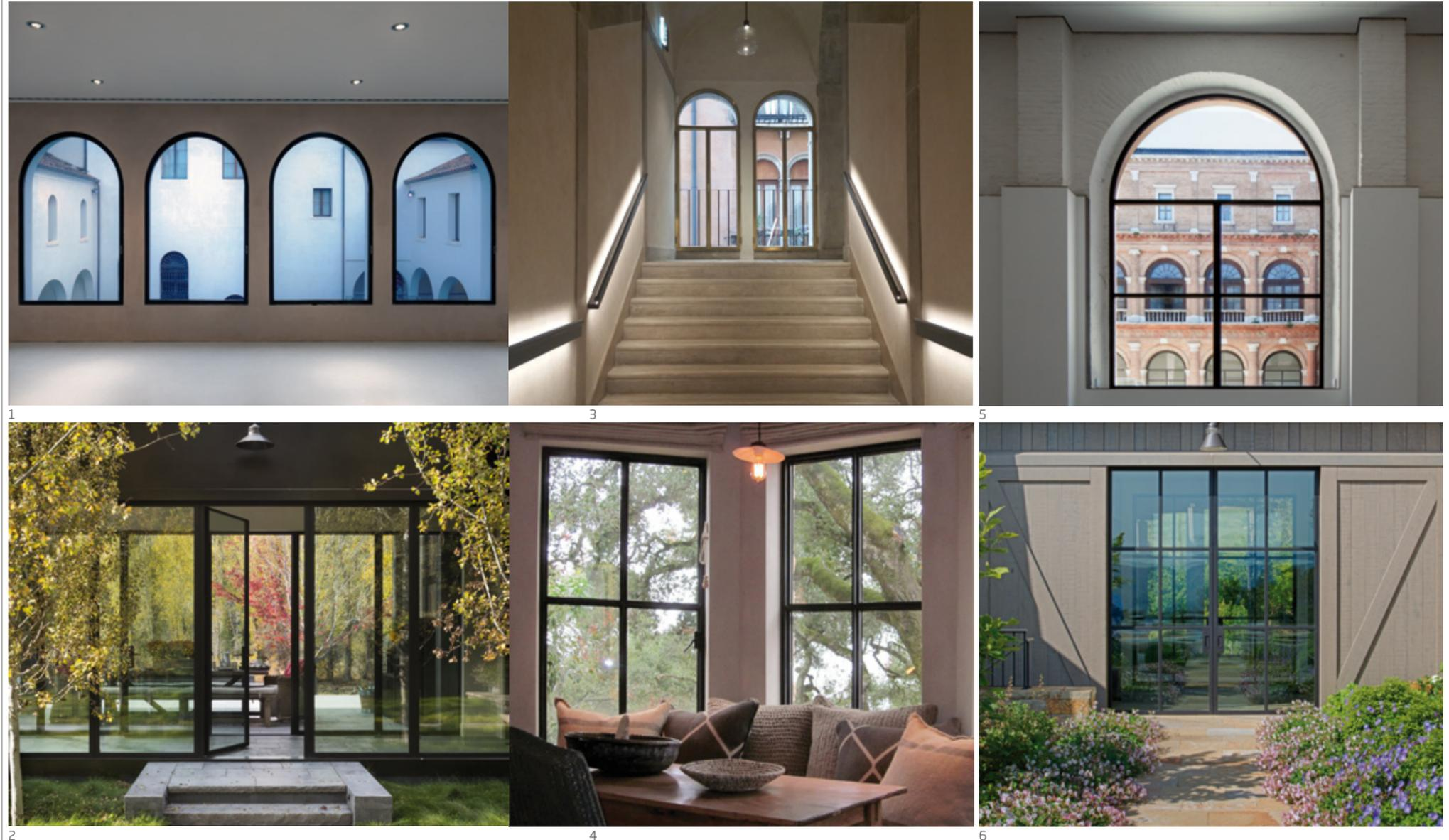
1. Ouverture à bascule pour les grandes fenêtres en arc : un profilé unique, fin et continu, encadre le verre. Avec les paumelles invisibles, la ligne de l'hubrisserie reste constante et propre sur tout le périmètre de la menuiserie.
